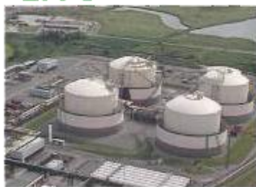
LNG Storage at Peakshaver
