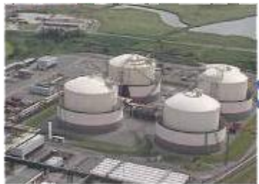
LNG Storage at Peakshaver
